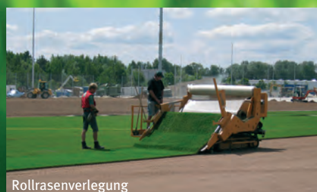
Rollrasenverlegung
