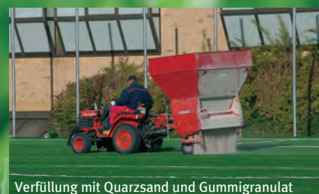
Verfüllung mit Quarzsand und Gummigranulat
