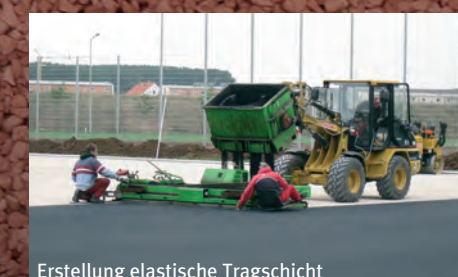
Erstellung elastische Tragschicht
