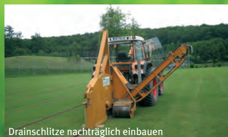
Drainschlitze nachträglich einbauen
