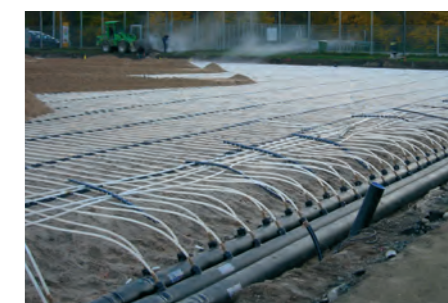
Moderne Technik unterstützt.
